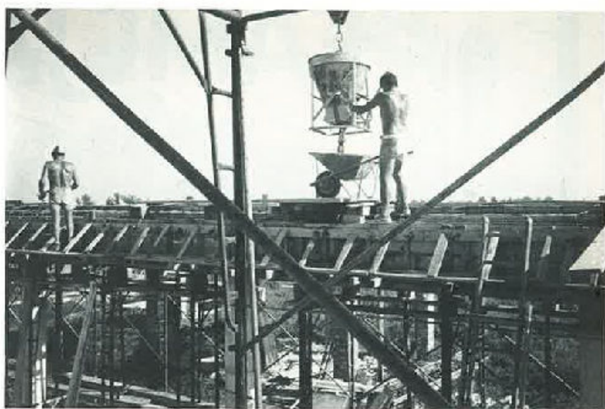
L'instancabile Sergio Zavarise, il giovane capo cantiere, sta effettuando una delicata operazione di ... travaso.
